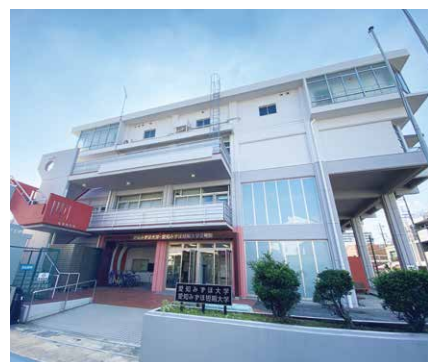
改修前の2号館
